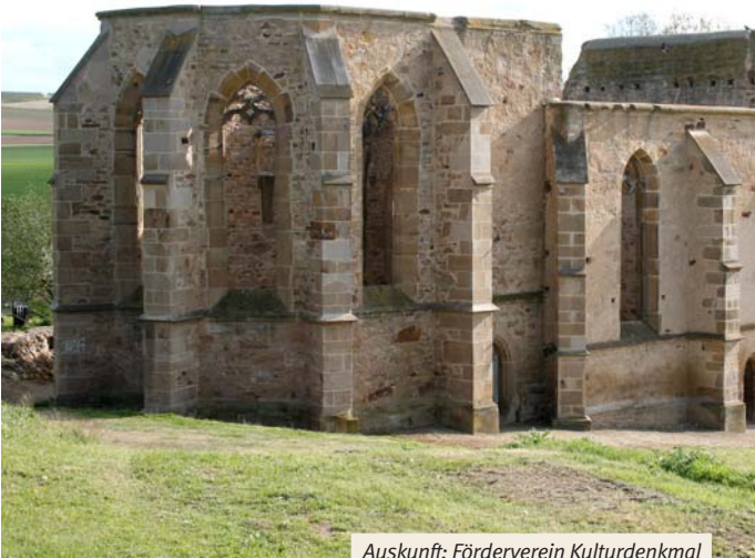
Ruine der sog. "Beller Kirche" von Norden
