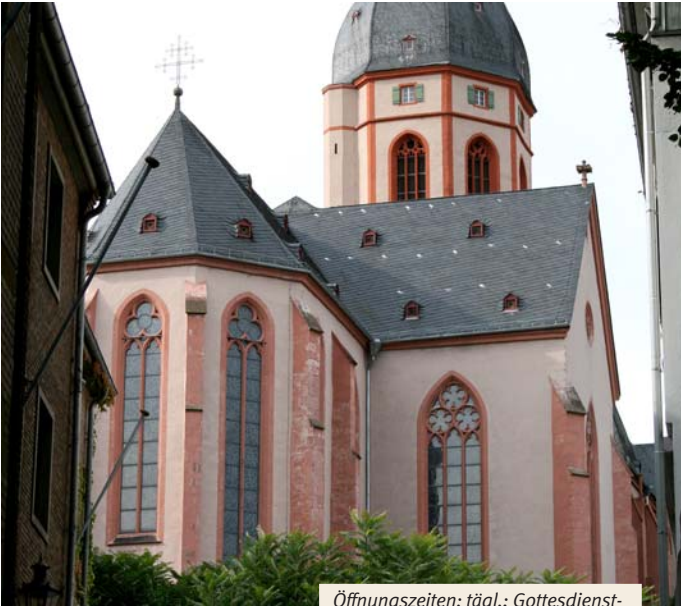
Ansicht von Osten
