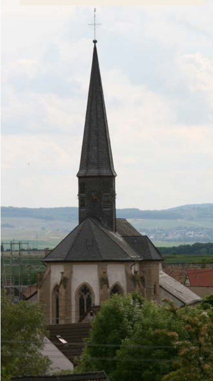
Ansicht von Osten
