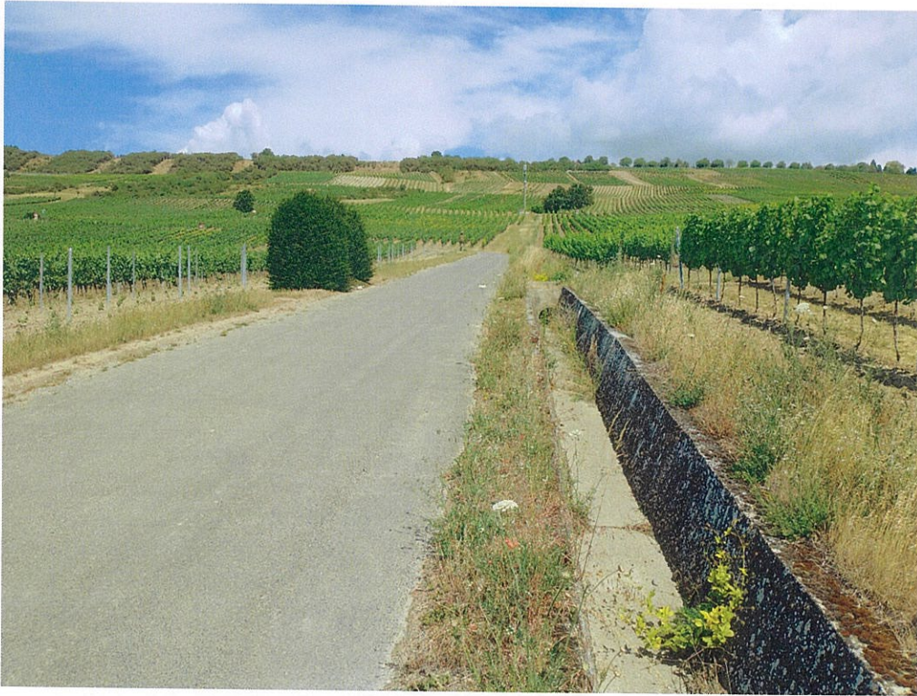
Bild 5: Abschnitt 2, Blick Richtung Norden, Betonprofil Entwässerungsgraben
