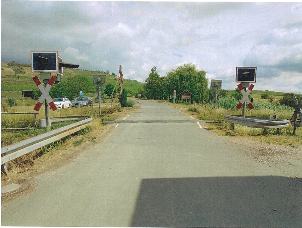
Bild 1: Abschnitt 1, am Baubeginn, Blick Richtung Norden
