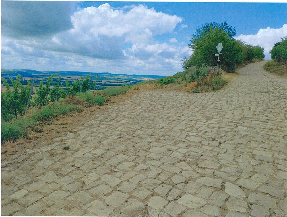
Bild 15: Abschnitt 6, Blick Richtung Westen
