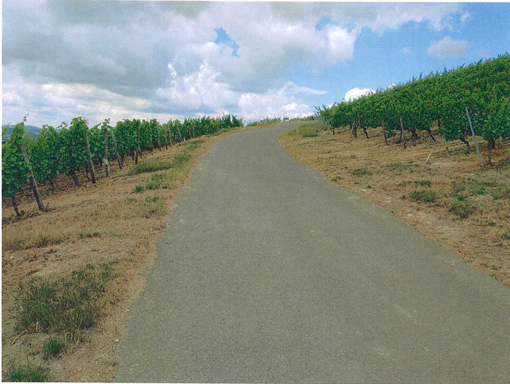
Bild 13: Abschnitt 6, Blick Richtung Westen
