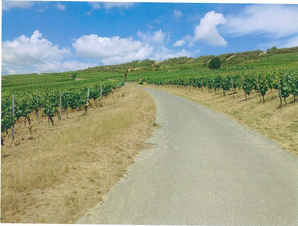
Bild 7: Abschnitt 3, Blick Richtung Westen
