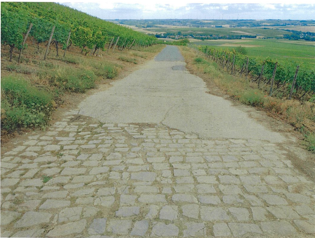
Bild 14: Abschnitt 6, Blick Richtung Osten, Übergang Asphalt / Pflaster bzw. Betonfläche
