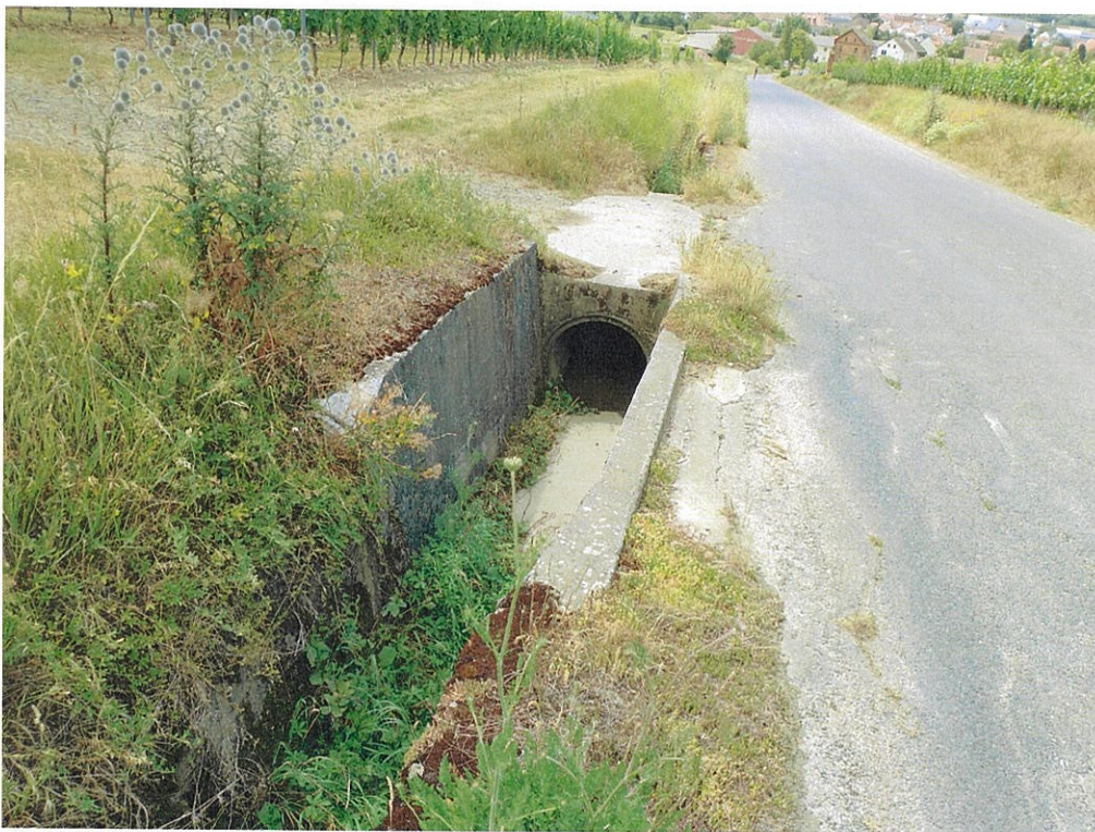
Bild 4: Abschnitt 2, Blick Richtung Süden, Betonprofil Entwässerungsgraben
