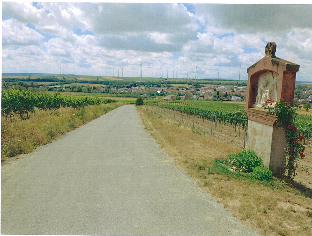
Bild 6: Abschnitt 2, Blick Richtung Süden
