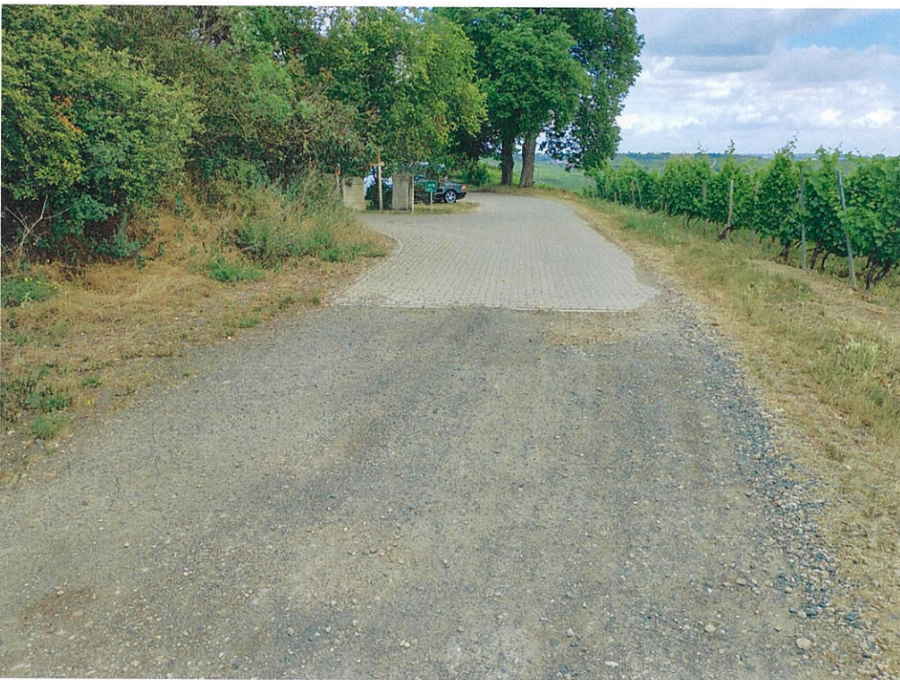
Bild 18: Abschnitt 7, Blick Richtung Westen, Bauende, Anschluss an Pflasterfläche
