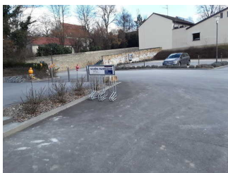
Weg zum Haupteingang 8 m lange Schräge 4%
